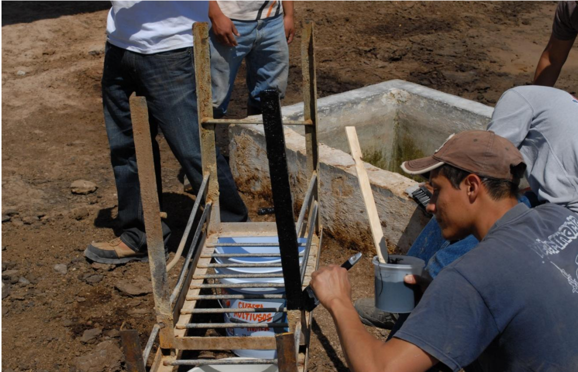
Ilustración 7. Aplicación de Recubrimiento Hidráulico Negro
