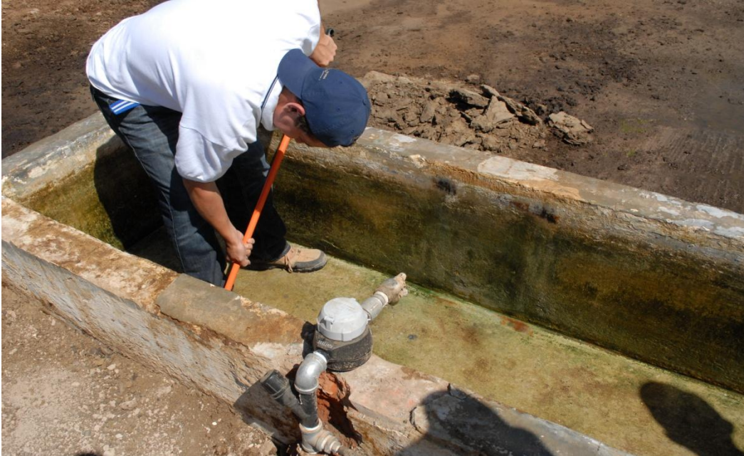
Ilustración 6. Aplicación de SealXPro NanoTech-C/P
