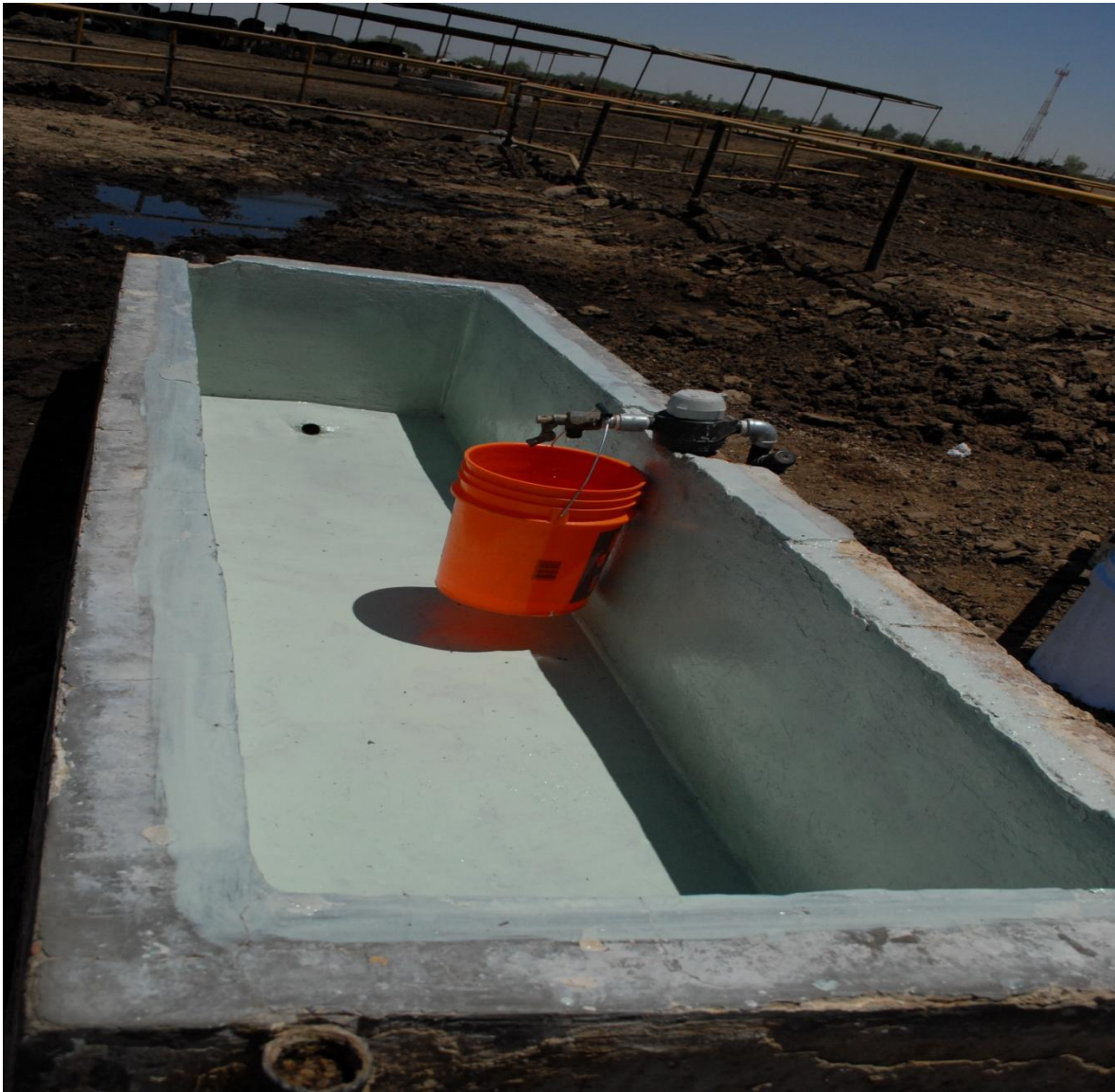
Ilustración 8. Aplicaciones de Recubrimiento epóxido impermeable.
