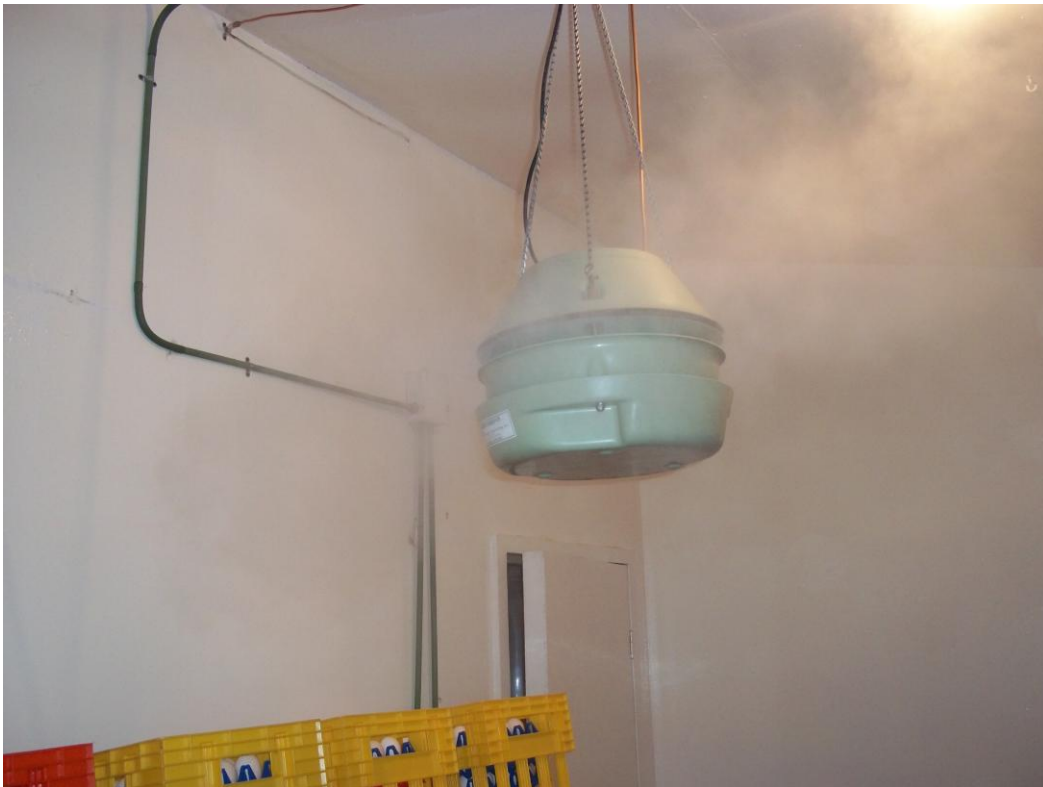
Figura 11: En esta fotografía se muestra un humidificador tipo hongo proporcionando humedad al cuarto frío.
