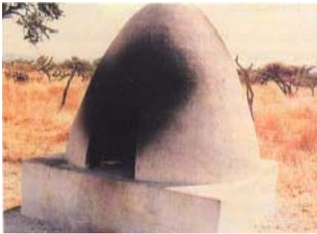
Incinerador tipo panadería
