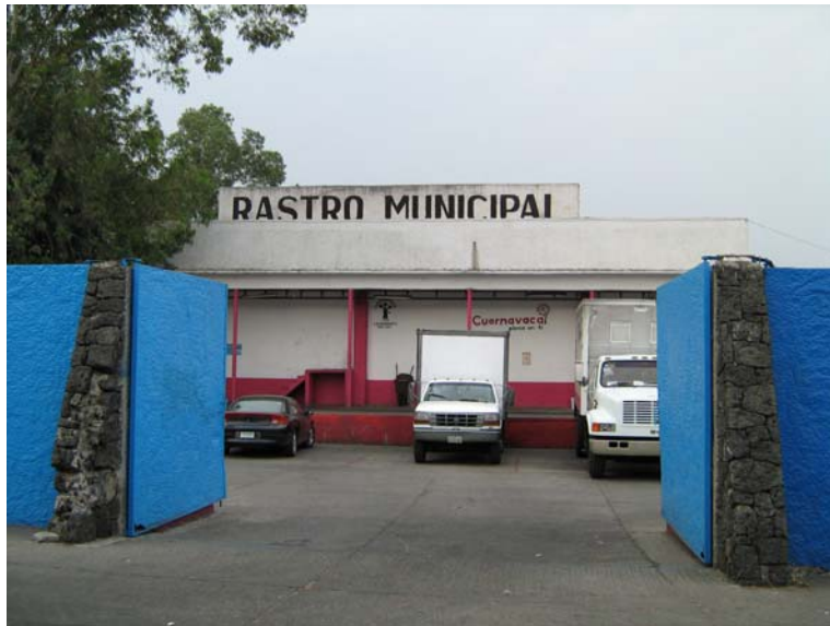
IMAGEN 9.- Acceso al área de carga.
