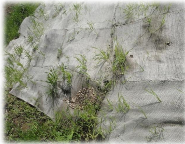
Figura 44.-Retención del suelo sobre la malla
