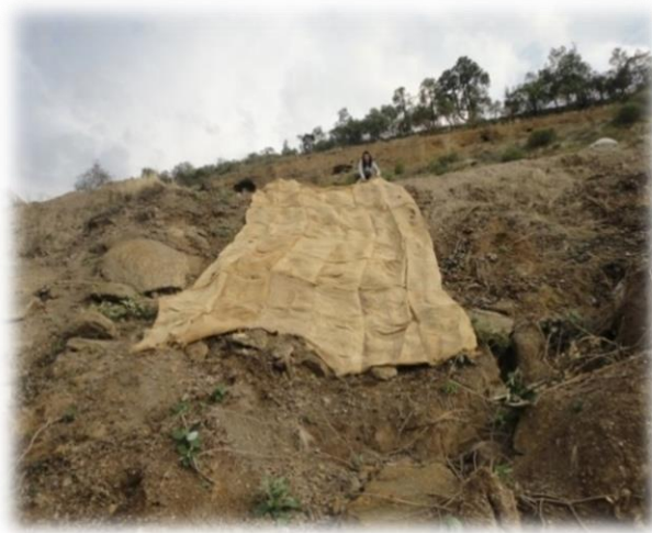
Figura 33.-Colocación de la malla
