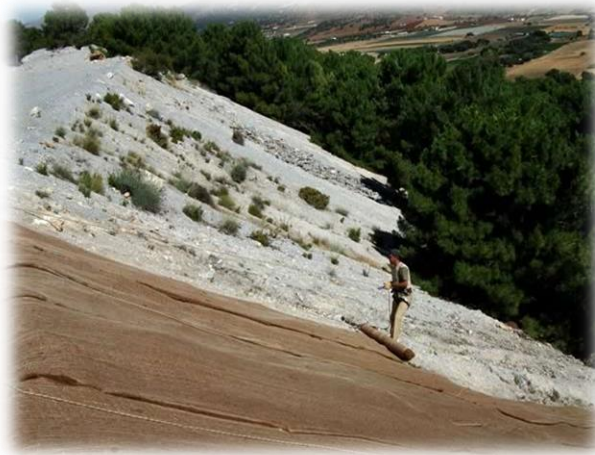
Figura 6.-Colocación de la malla, en una superficie de muy poca vegetación (Paisajes del Sur, 1988).
