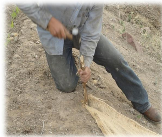
Figura 34.-Clavando las estacas
