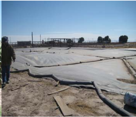
Superficie de la cámara de biodigestión
