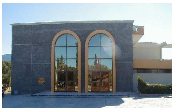
Fig. No. 9 Edificio José A. de la Garza Cabello.
