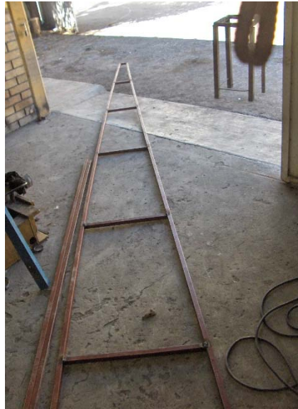
Fig.3.6. Construcción de aguilones
