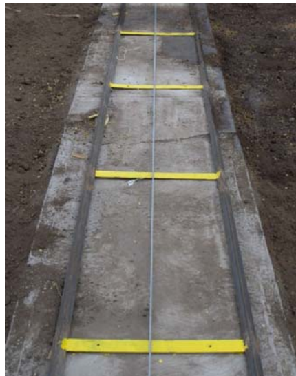
Fig.3.7. Construcción de los rieles
