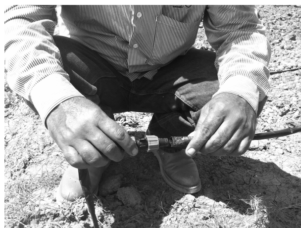
Figura 1.12. Reparación de Lateral con Cople.
