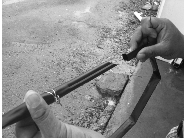
Figura 1. 13 Reparación de Lateral con Manguera Ciega.
