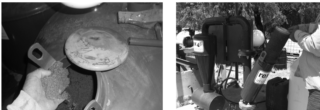
Figura 1.19. Revisión de Arena y Elemento de Malla.
