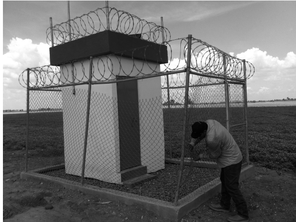
Figura 1.22. Reparación de Cerco en Caseta de Bombeo
