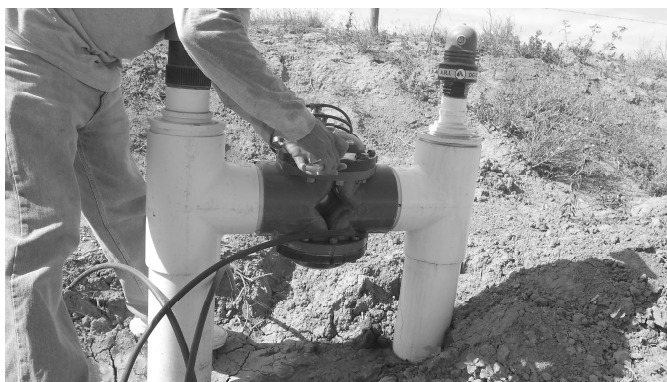
Figura 1.25. Revisión de Válvulas de Seccionamiento.
