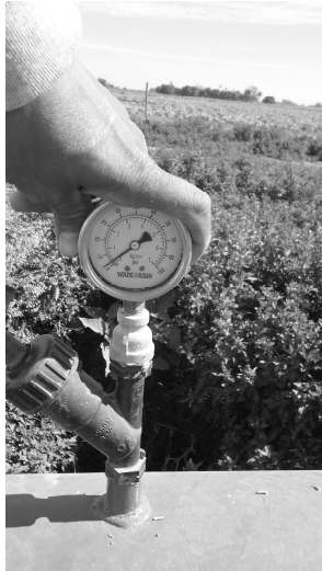
Figura 1.20. Reemplazo de Manómetro de Glicerina
