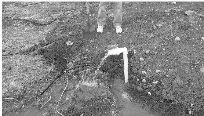
Figura 1.24. Lavado de Tuberías Secundarias.
