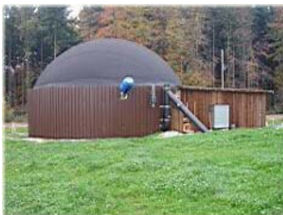
Figura 9: biodigestor con estructura semiesférica de polietileno de película delgada
