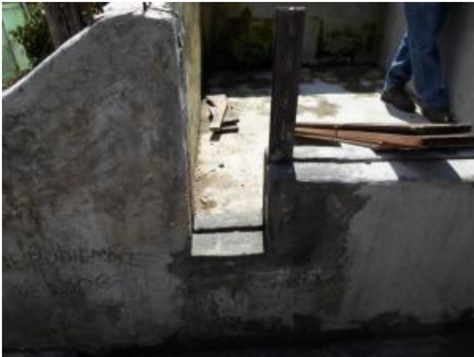
Figura 11. Abertura de la pared del tanque para su modificación
