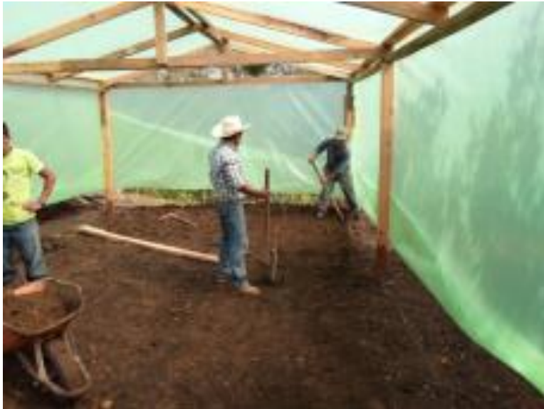
Figura 12. Estructura del secador solar
