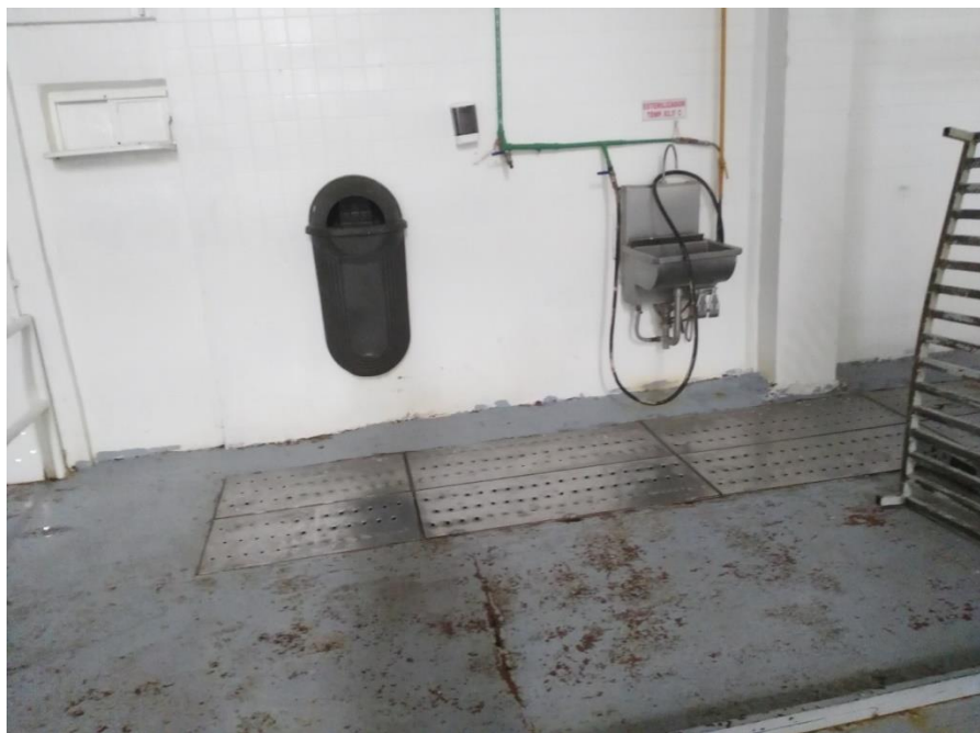
Figura 45. Piso en el Área de Terneras
