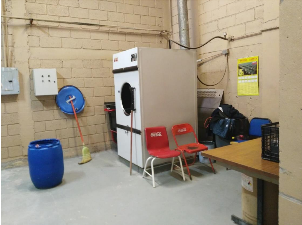
Figura 5. Sala de Espera de Lavanderia.
