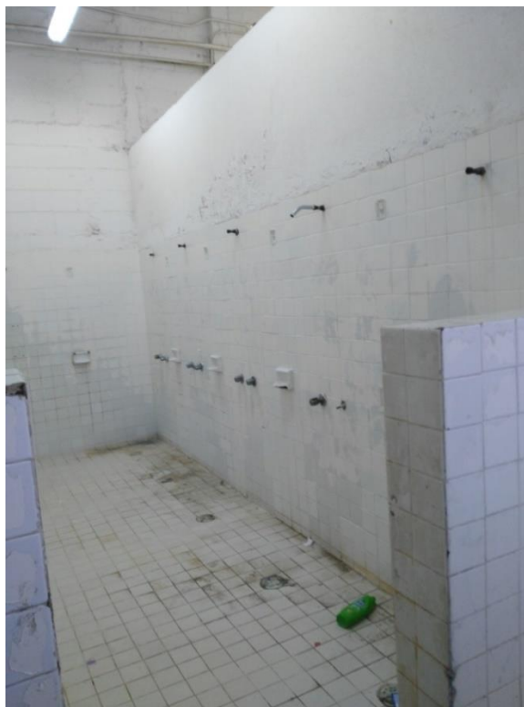
Figura 41. Regaderas de los Operarios.
