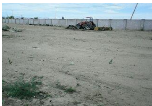
Figura 6. Nivelación del terreno.
