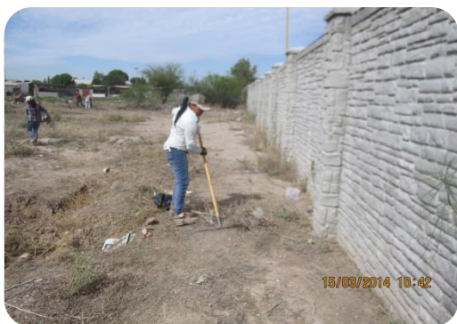
FIGURA 3. Limpieza del terreno
