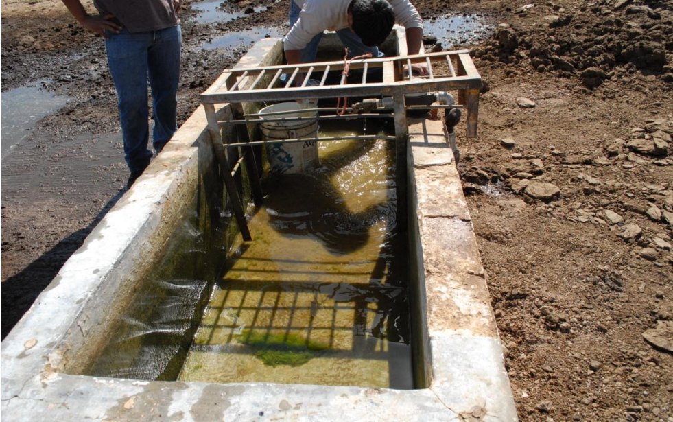
Ilustración 6 limpieza y desinfección de la pila con el producto (Fuente propia)
