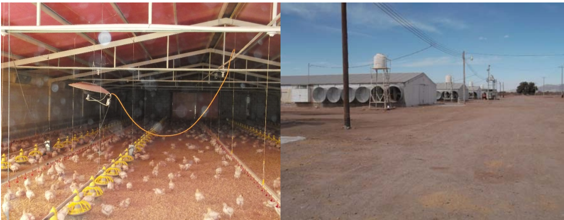
Figura 6. Equipamiento de una nave de ambiente controlado
