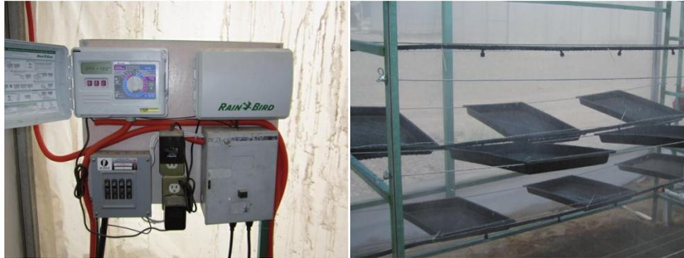
Figura 16. Sistema de riego por nebulización automatizado para la producción de FVH.
