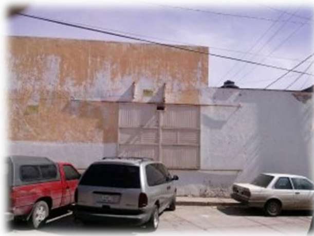
Estacionamiento del Rastro y recepción de ganado
