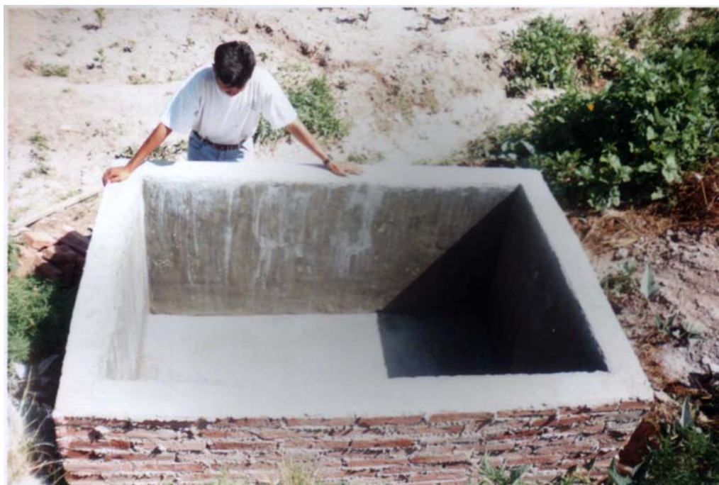
FIGURA 3. Tanque utilizado para almacenar agua y utilizarla en el riego por goteo.
