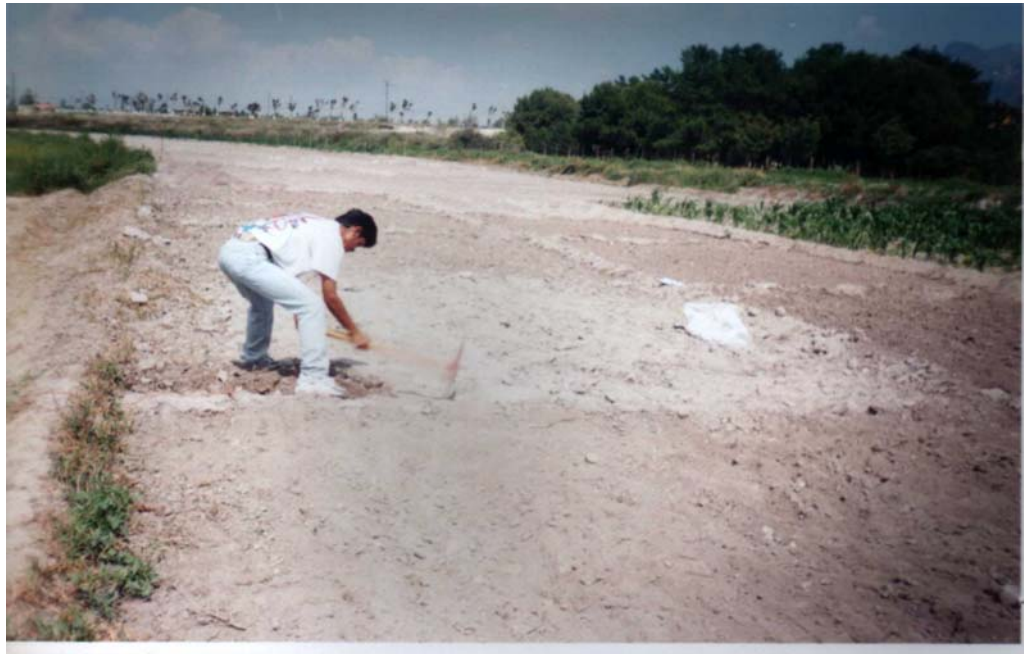
FIGURA 1. Preparación del terreno de Forma Manual
