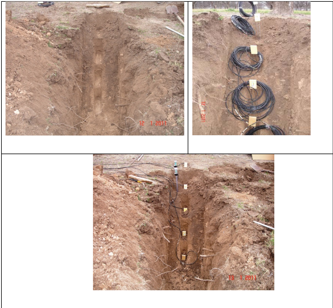
Figura 2 Instalación de los sensores de humedad del suelo (TDR) a las profundidades de 0-30, 30-60, 60-90, 90-120 y 120-150 cm en una huerta de nogal pacanero Zaragoza Coahuila.
