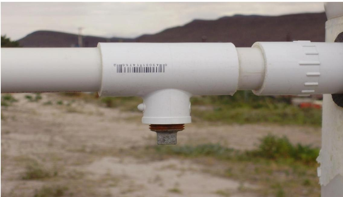
Figura 18. Válvulas para Toma de Muestras.
