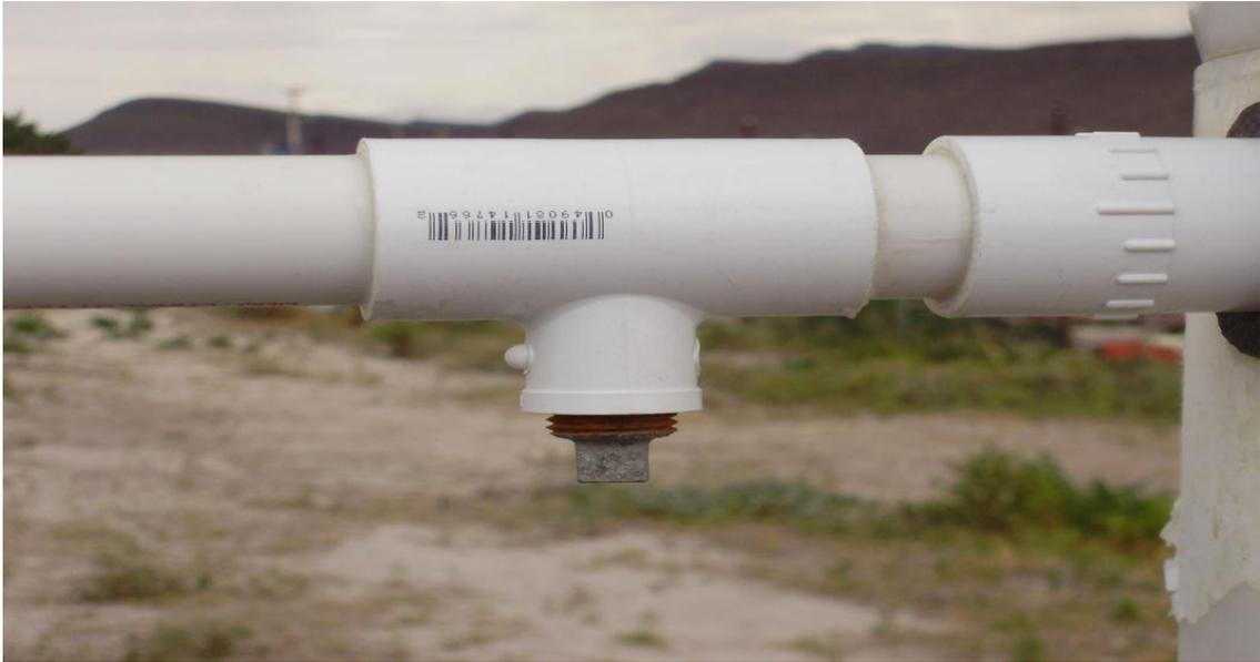
Figura 10. Válvula para Toma de Muestras
