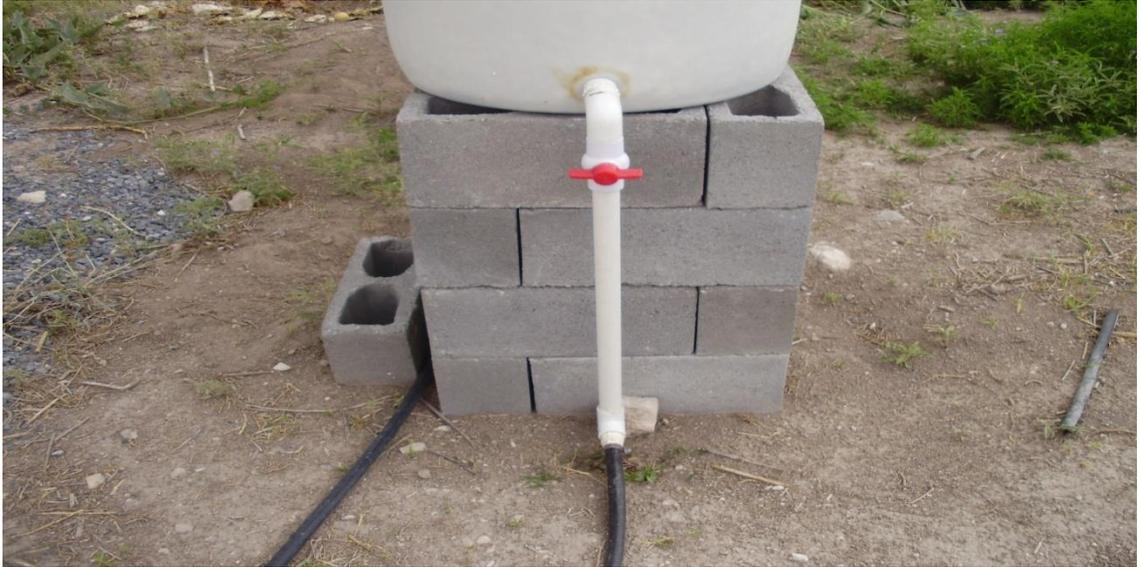
Figura 13. Instalación de Válvula Reguladora de Gasto
