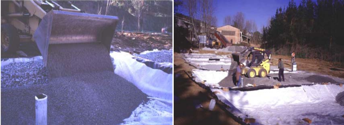
Figura 23. Izquierda: colocación del material granular desde el exterior de la celda. Derecha: colocación del material granular con maquinaria ligera desde el interior de la celda (García y Corzo, 2008).
