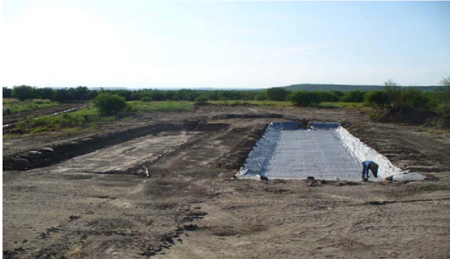
Figura 8. Excavación y recubrimiento de un humedal construido.
