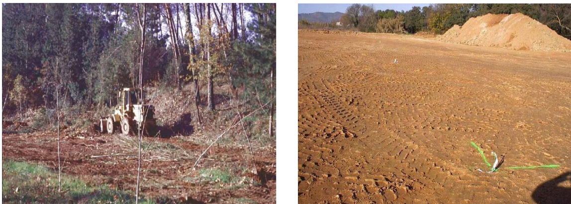
Figura 18. Actividades de desbroce, limpieza y construcción de una plataforma de trabajo (García y Corzo, 2008).
