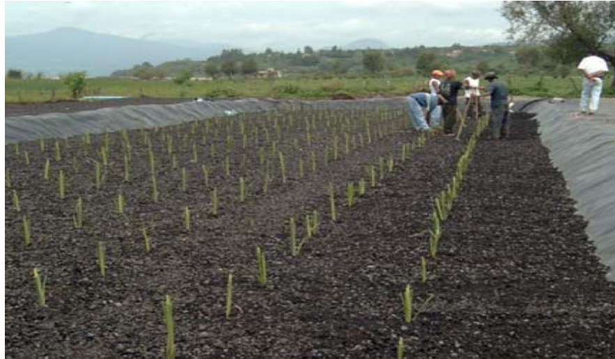
Figura 24. Operación de plantación de carrizo en un sistema de flujo subsuperficial (Urquiza et al. , 2006).
