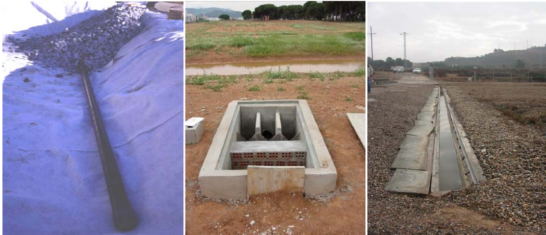
Figura 21. Colocación de tubería de salida (Izquierda), arqueta de repartición (Centro) y canal de vertido (derecha) en un humedal de flujo horizontal (García y Corzo, 2008).
