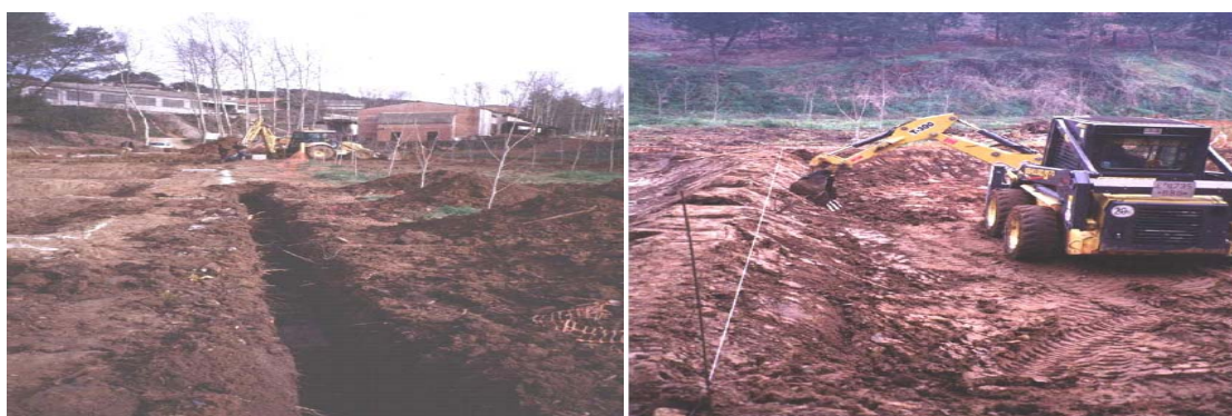
Figura 19. Excavación de zanja y conformación de taludes durante la construcción de un sistema de humedales construidos (García y Corzo, 2008).
