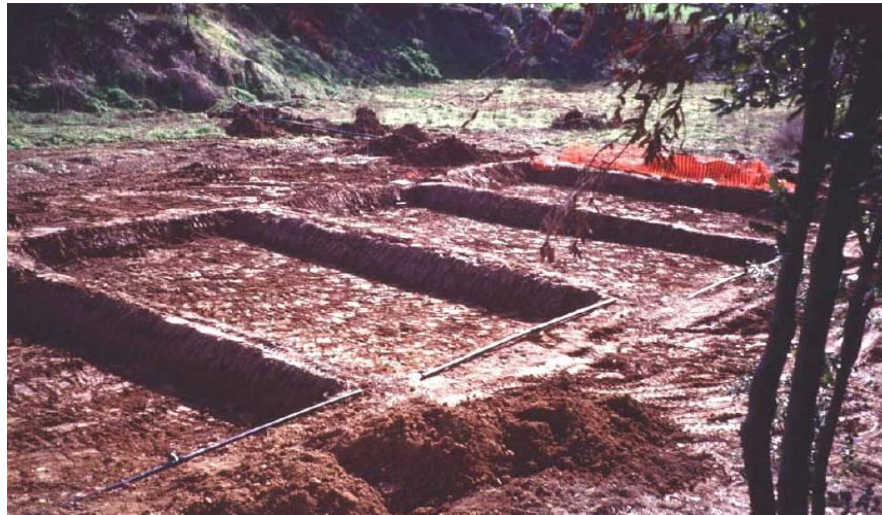
Figura 20. Conformación de taludes de las celdas de un sistema de humedales (García y Corzo, 2008).
