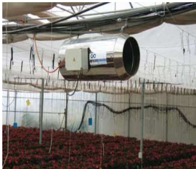
Figura 2.5: Sistema de combustión directa (cañón).
