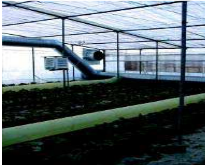
Figura 2.4: Distribución del calor mediante mangas perforadas de polietileno para un sistema de combustión indirecto.
