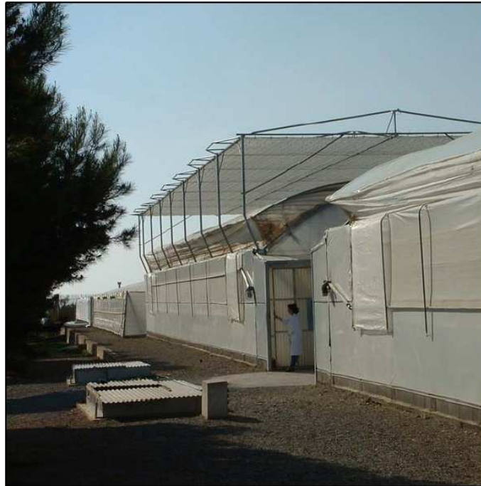
Figura 2.8: Pantalla de sombreo móvil exterior al invernadero (Pilar Lorenzo, CIFA, Almería).
