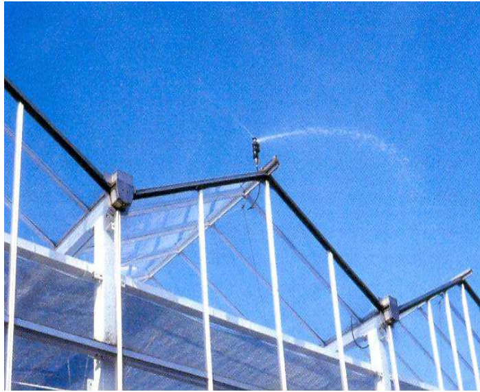
Figura 2.14: Riego de cubierta
