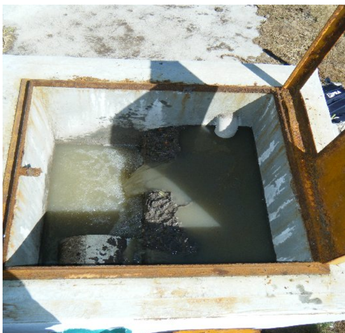
Figura 5. Ubicación del punto uno; descarga del agua residual
