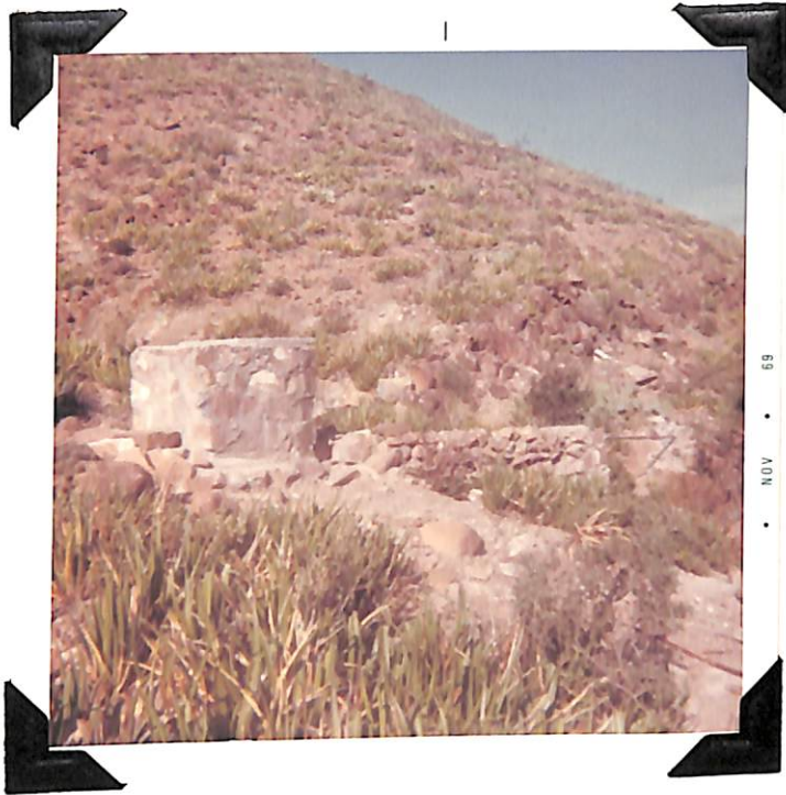
Foto. 1. Rompepresiones forma de proteger la tubería de la presión
