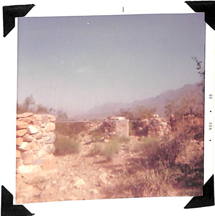
Foto. 2. Protección de la tubería al pasar por un arroyo - que cruzó en el trayecto.
