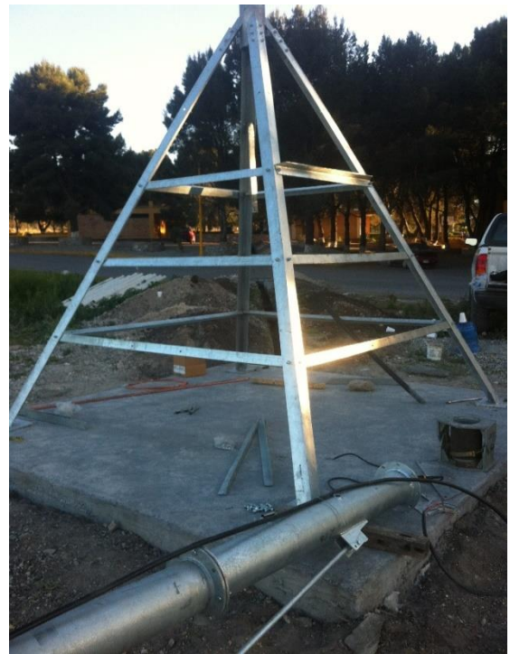
Figura 15. Instalación y terminación del punto pivote
