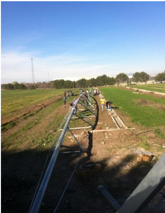
Figura 20. Vista preliminar del ensamble de una armadura
