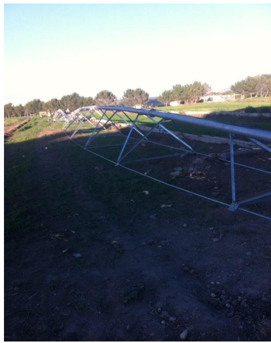
Figura 20. Vista preliminar del ensamble de una armadura
