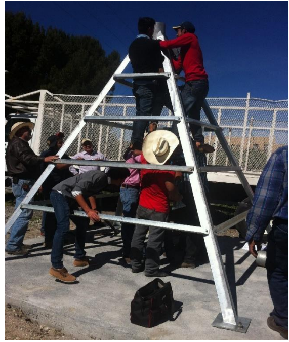
Figura 14. Ensamble del punto pivote
