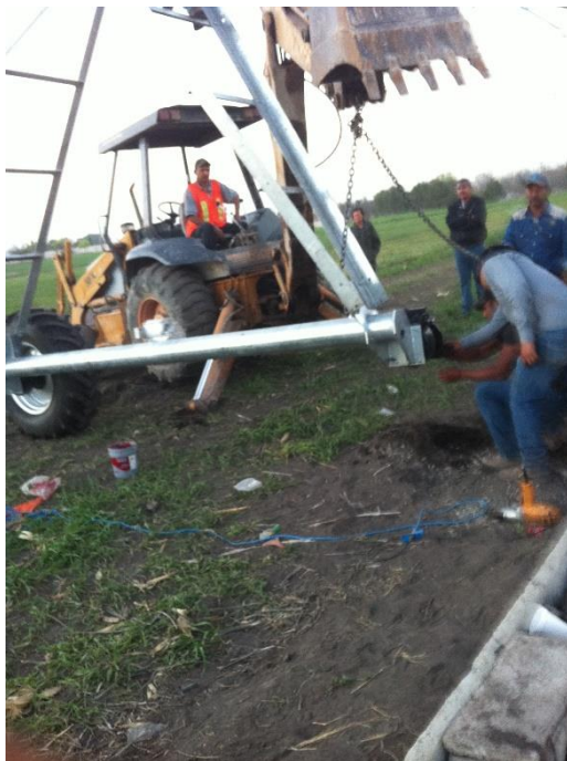
Figura 24. Ensamble del tren de transmisión
