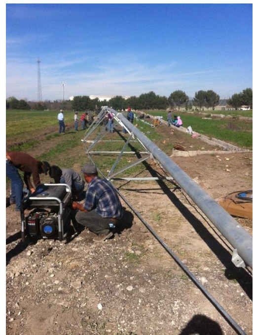
Figura 19. Ensamble estructural de la armadura de arranque
