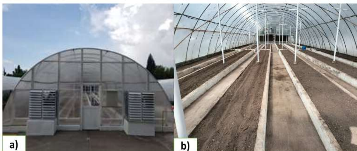
Figura 13. a) Imagen de la fachada del invernadero No. 5, b) Interior del invernadero. Fuente: Imagen propia, 2025.
