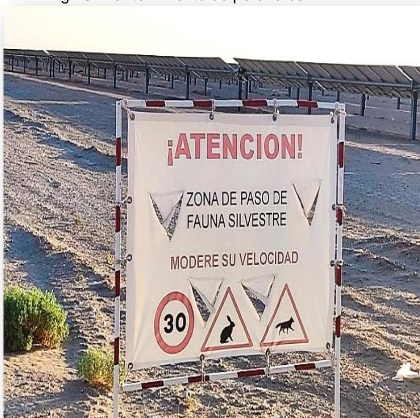
Fig.27. Instalación de lonas informativa
