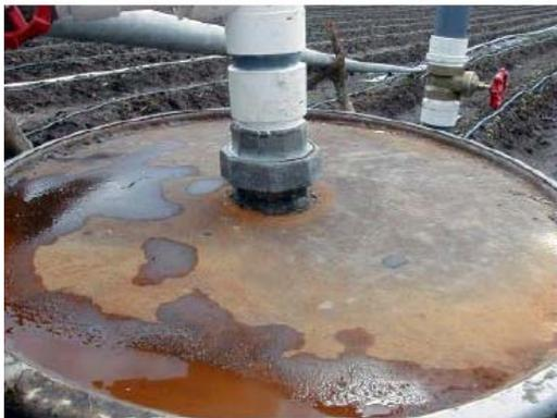
**Figura 40. Conexión de entrada Del filtro de barril.**
