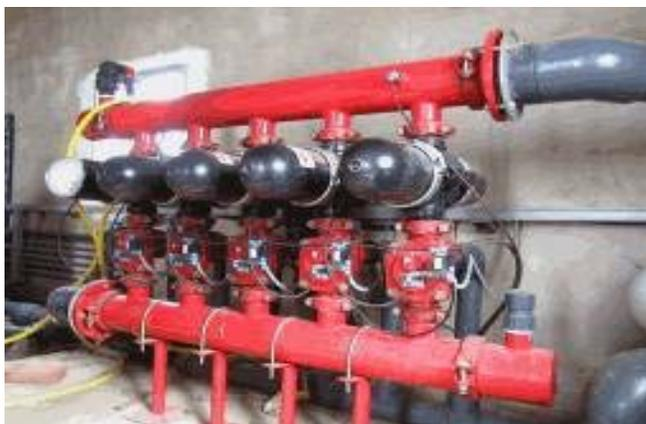
**Figura 20. Instalación de Filtros de Anillas en paralelo de limpieza automática.**
