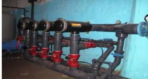
**Figura 64. Filtros de anillas semiautomáticos con capacidad de limpieza máximo de 160 m<sup>3</sup>/h**
