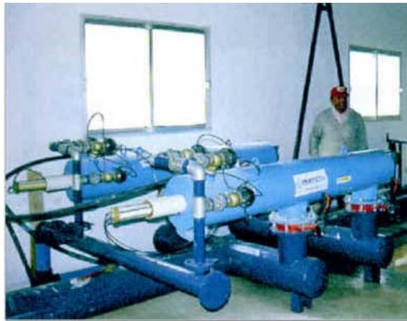
**Figura 62. Montaje de una estructura de filtros automáticos de malla.**
