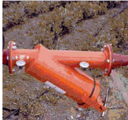
Figura 6. Instalación de filtros de malla con soporte metálico.
