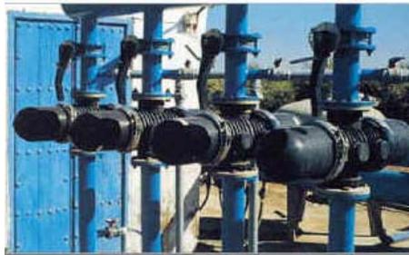
**Figura 12. Filtros de Anillas Conectados en paralelo.**
