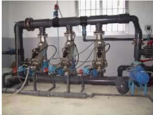
**Figura 61. Instalación de filtros automáticos.**
