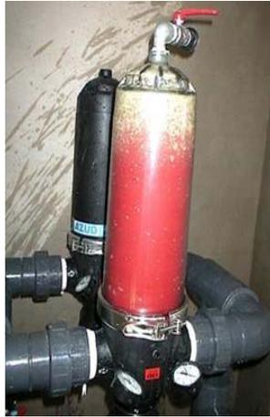
**Figura 18. Filtro de anillas saturado.**
