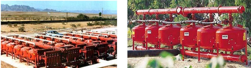
Figura 21. Sistema de filtros de arena conectados en paralelo.
