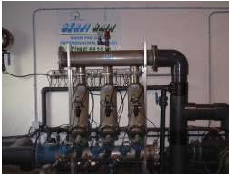
**Figura 57. Montaje de Filtros SATI.**
