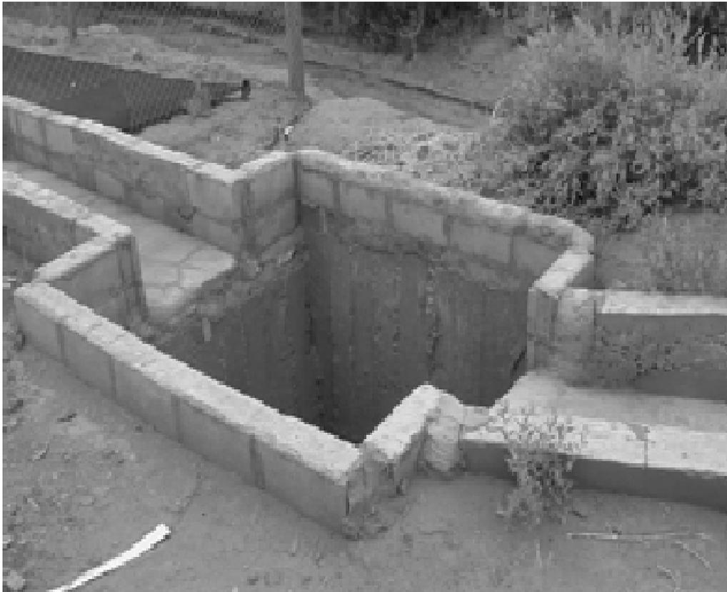
**Figura 71. Desarenador con un diseño inapropiado.**
