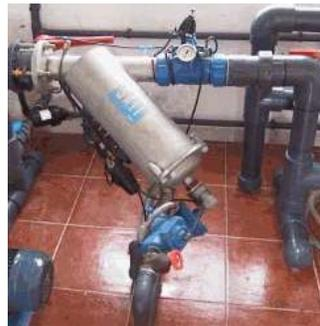
**Figura 60. Montaje de filtro automático de 3".**
