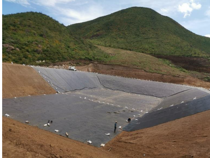
ILUSTRACIÓN 5 MEMBRANA PARA ALMACENAR AGUA DE RIEGO (FUENTE PROPIA).
