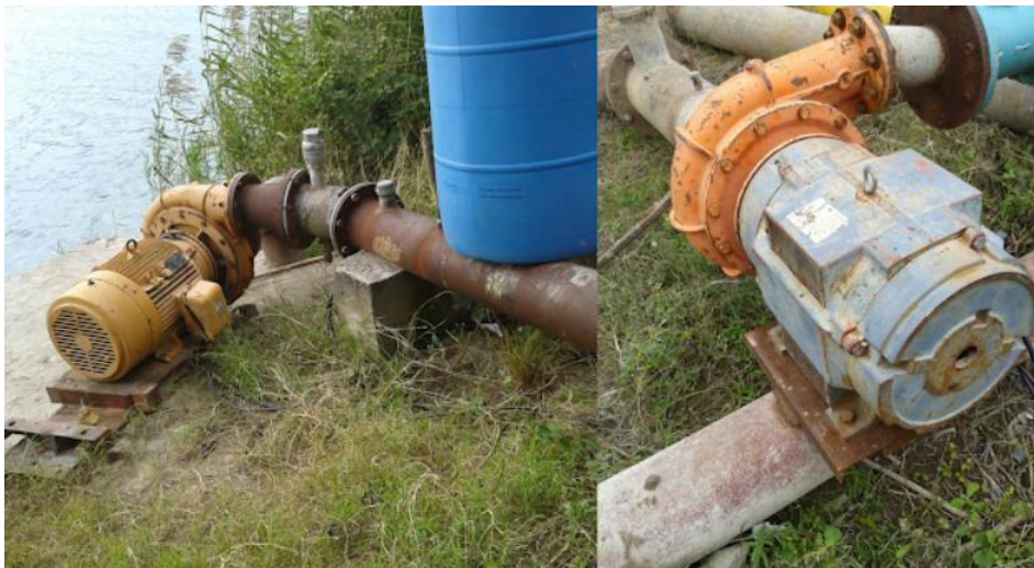
ILUSTRACIÓN 7 TÍPICA BOMBA CENTRIFUGA HORIZONTAL (FUENTE, JIMÉNEZ, 2017).
