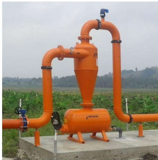
ILUSTRACIÓN 11 FILTRO DE TIPO HIDROCICLÓN DE LA MARCA NETAFIM (FUENTE, NETAFIM)
