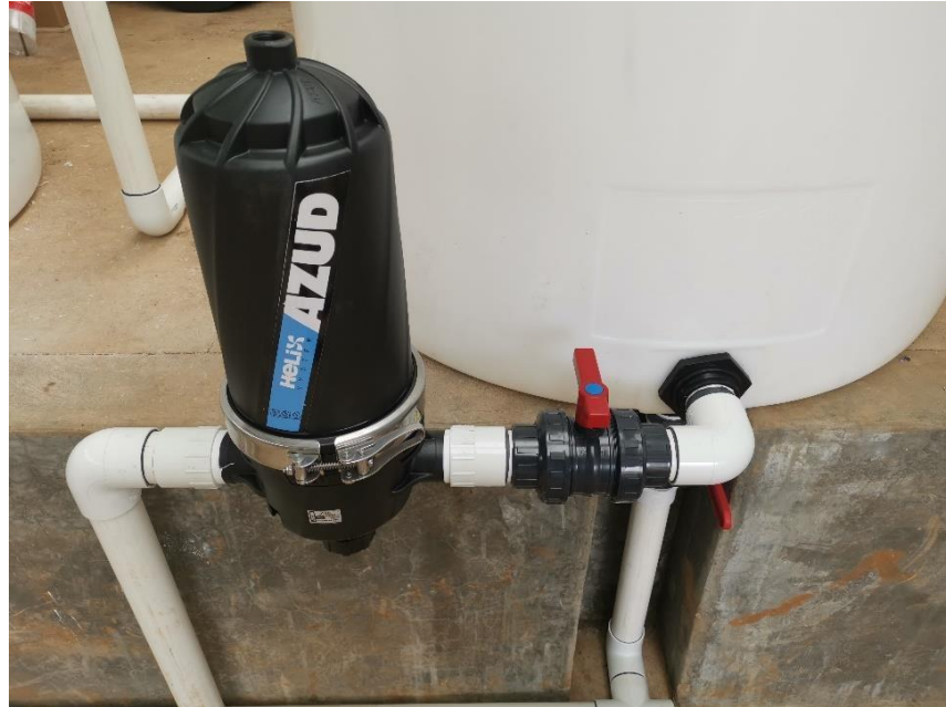
ILUSTRACIÓN 14 FILTRO DE ANILLOS DE LA MARCA AZUD (FUENTE PROPIA).
