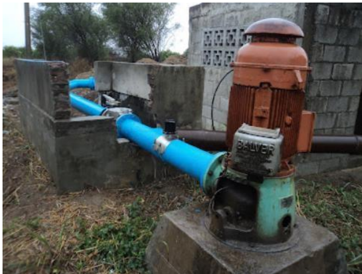
ILUSTRACIÓN 9 BOMBA TURBINA VERTICAL (FUENTE, JIMÉNEZ, 2017).
