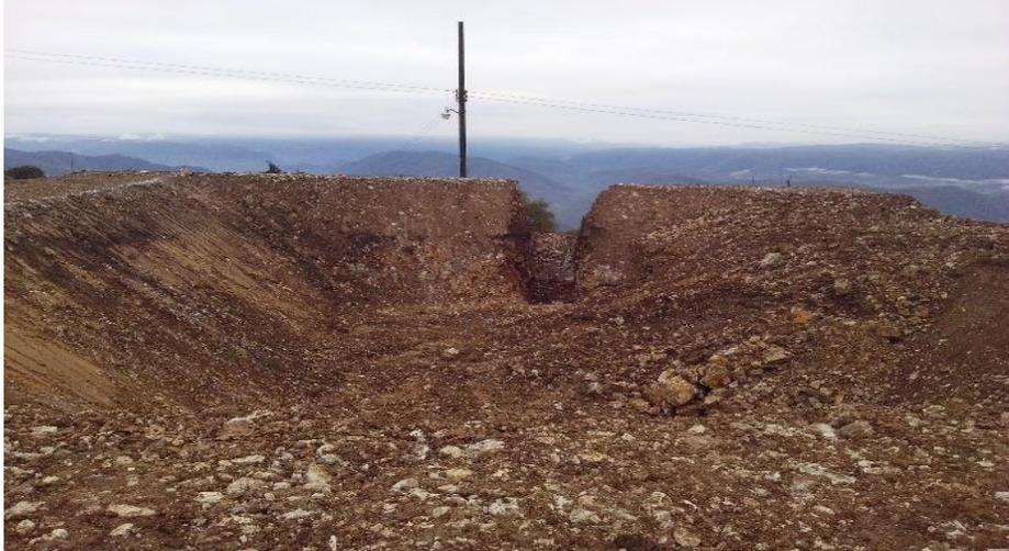
Zanja para salida de tubería de línea de conducción y tubería de desagüe
