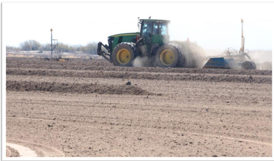
Figura 1. Preparación del Terreno Nivelando con Equipo de Rayo Laser
