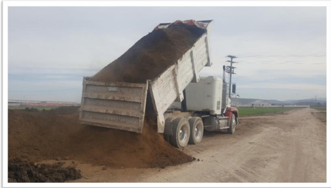
Figura 2. Camión de Volteo vaciando estiércol en el área de trabajo
