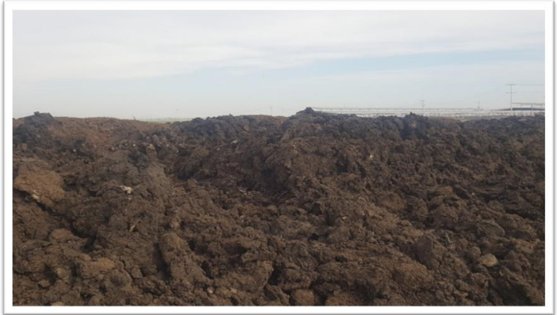
Figura 3. Colocación del estiércol apilado en la parcela de trabajo
