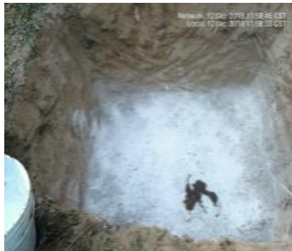
Fotografía: Nelvi Pérez Gálvez Construcción de fosa séptica en la Unidad de Producción Pecuaria del productor Luis Romo Gutiérrez. Ejido Nueva Fracción de, San Buenaventura, Coahuila.
