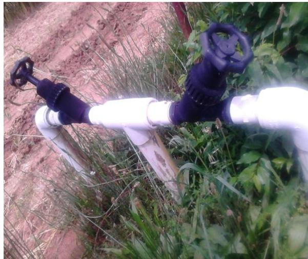
**Figura 3.4.**Las válvulas de seccionamiento de paso angular RM de 2" oblicuas PLASSON.
