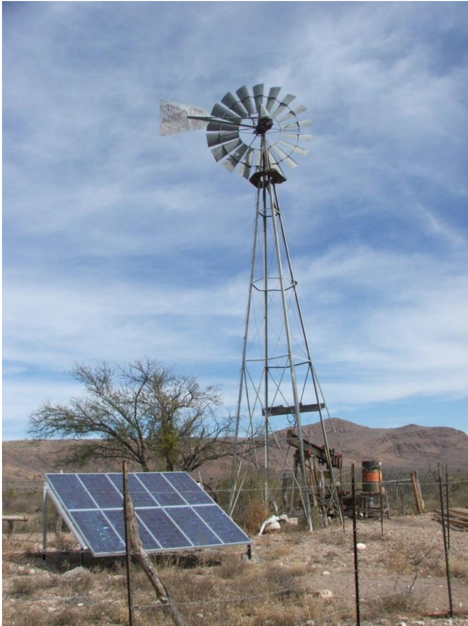
Figura 31. Detalle de pozo con papalote y equipo fotovoltaico, este abastece de agua a predios de los dos ejidos ya que se ubica en el centro de la línea divisoria
