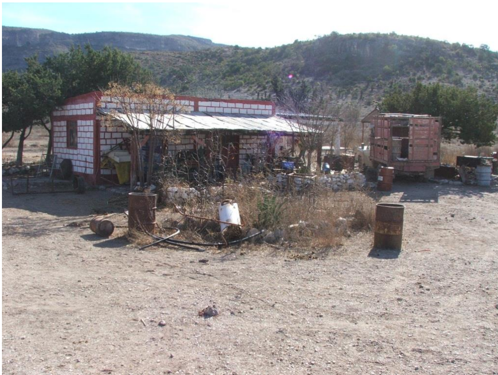
Figura34. Detalle de una construcción típica de concreto de un rancho en la zona de estudio.
