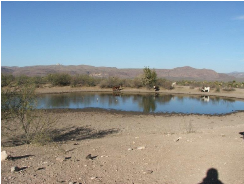
Figura 30. Detalle de bordo de abrevadero con menos de 50 % de su capacidad de agua, casi la totalidad de obras de este tipo se ubican en la parte baja de los ejidos y las pocas que se ubican en las partes altas, casi nunca tienen agua
