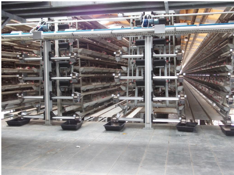
Batería de 6 niveles
