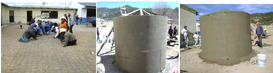
Figura 27.- Construcción de cisternas de ferrocemento por la comunidad y promoción del desarrollo de capacidades.
