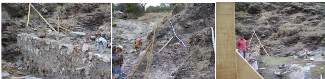
Figura 30.- Construcción de presa en la comunidad de Bacabureachi.
