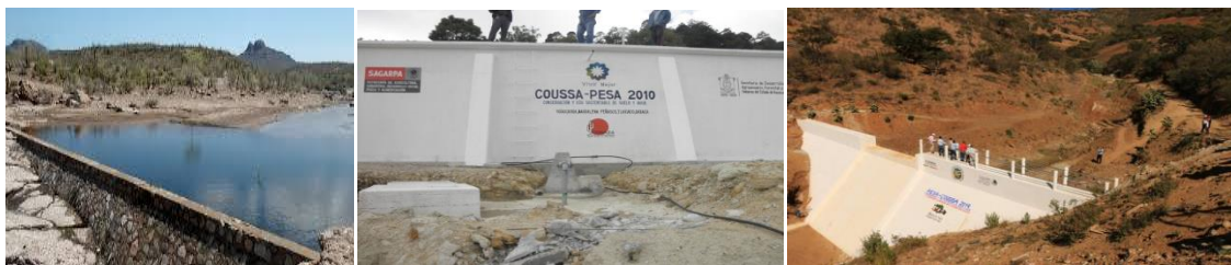
Figura 29.- Construcción de presas de mampostería en el programa COUSSA-PESA
