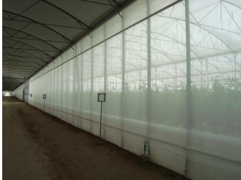
Figura 3.3. Ventila lateral que converge a un pasillo techado.
