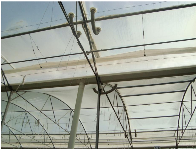
Figura 3.2. Ventila cenital del invernadero abierta al 50% de su capacidad.
