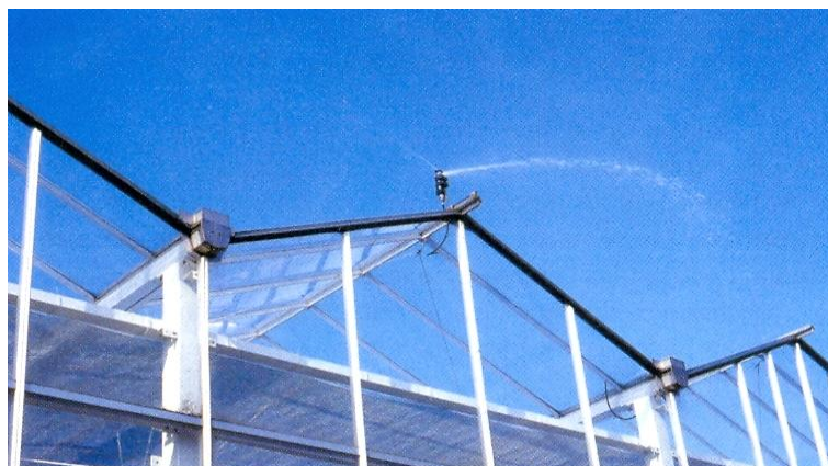
Figura 2.4 Riego de la cubierta.
