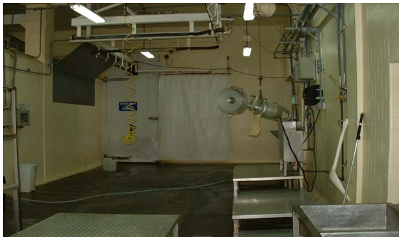
FIG 4.- SALA DE CORTADO Y PESADO DE CERDOS
