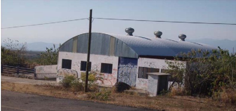
Vista de las instalaciones del rastro municipal, corral de espera y oficinas por el frente.
