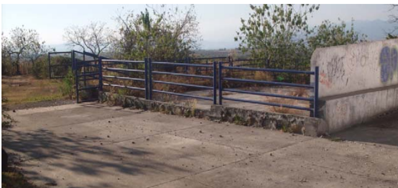
Corral de inspección sanitaria y espera de los bovinos para entrar a la trampa y área de sacrificio.
