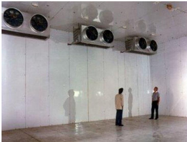
Figura 28. Cámara frigorífica constituida por una fila de serpentines fríos que lanzan aire por medio de ventiladores. http://infritec.com/camaras-frigorificas-paneles-3-m/
