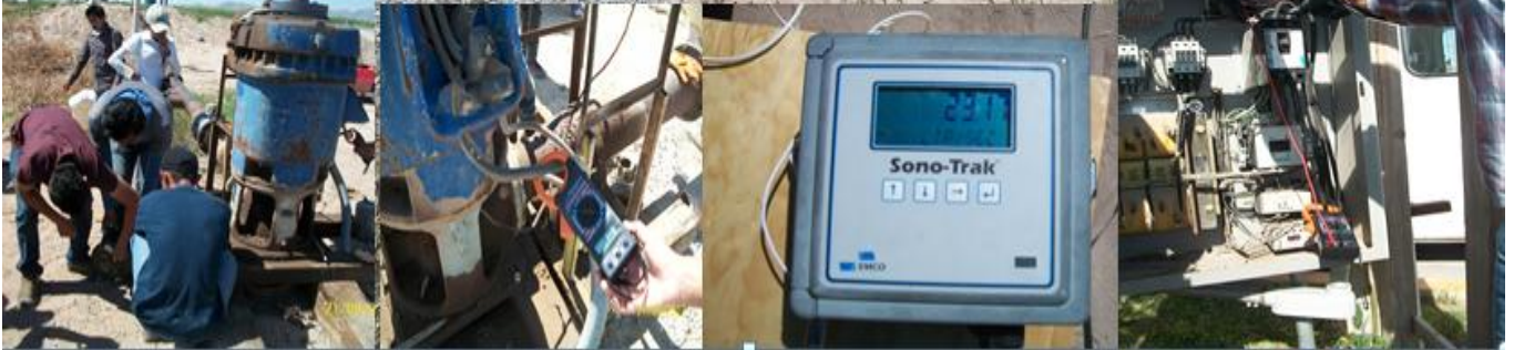
Figura 17. Equipo de trabajo y materiales utilizados en la evaluación del pozo 2050
