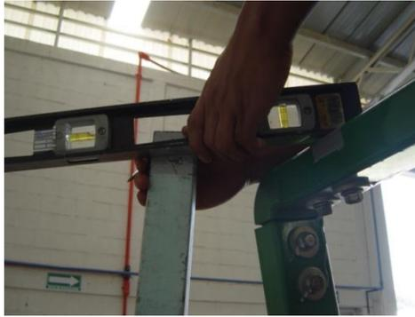
*Figura 68 Proyección de la altura del punto derecho*
