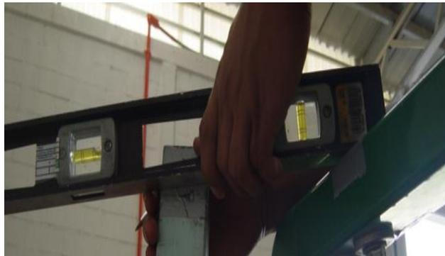
*Figura 67 Nivelación de punto derecho de la estructura*
