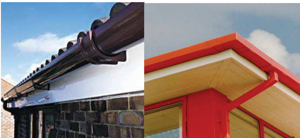
Fig 2.2 Formas de canaletas acordes a edificaciones (Philips, 2000).
