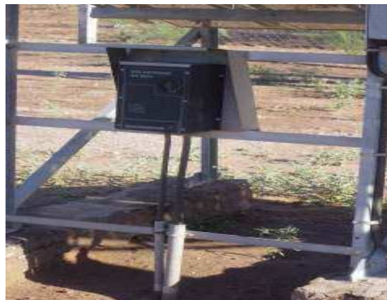
Fig. 2.6 Inversor de corriente que transforma 12 volts en 220 volts. (Kholer, 1975).
