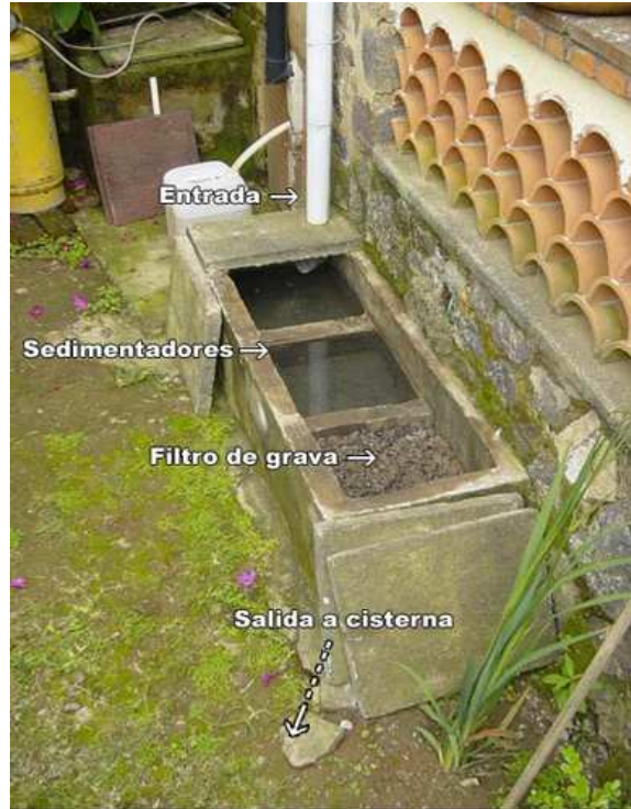
Fig. 2.4 Componentes de un filtro. (Gordon, 2005).
