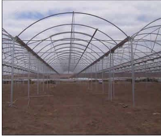
Fig.(3.2) Estructura del invernadero.
