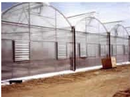
Fig.(3.1.5) Invernadero de doble capilla.
