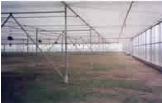
Fig.(3.5.11). Sistema de Enfriamiento Fog System .
