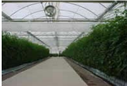
Fig.(3.5.8.1). Equipo de Ventilación.
