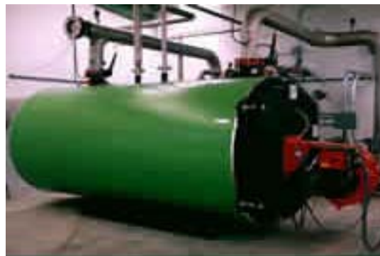
Fig.(3.5.10). Sistema de calefacción de aire
