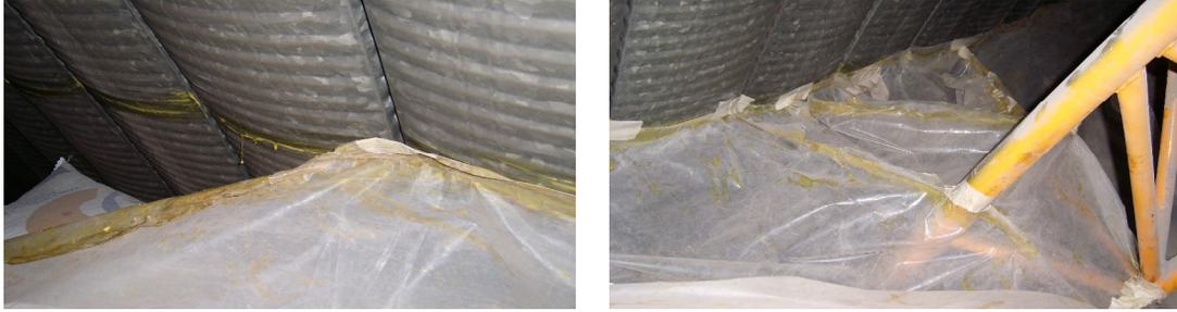
Figura 7.3 Forma de pegar los plásticos entre las estructuras para tener una mejor hermetización.
