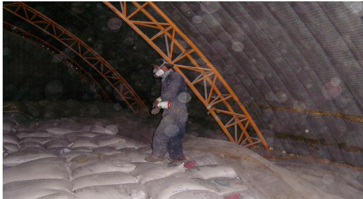
Figura 7.5 Distribución o aplicación del fumigante en estibas de semilla.
