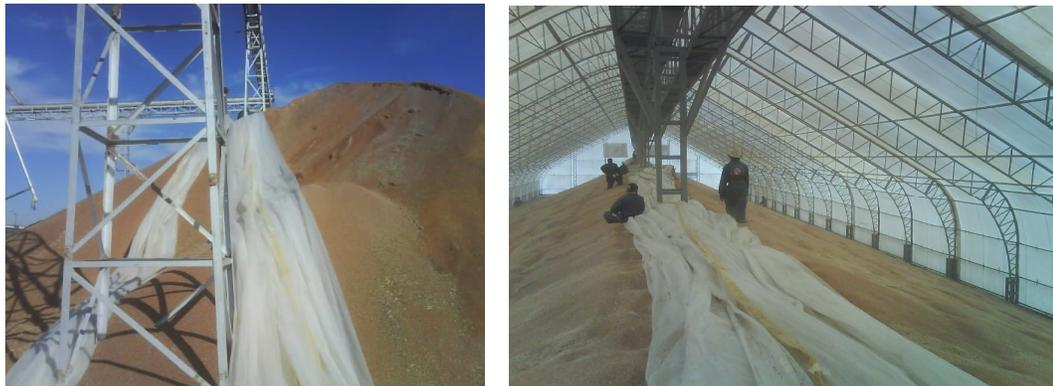
Figura 6.5 Acomodamiento del plástico sobre el grano almacenado.
